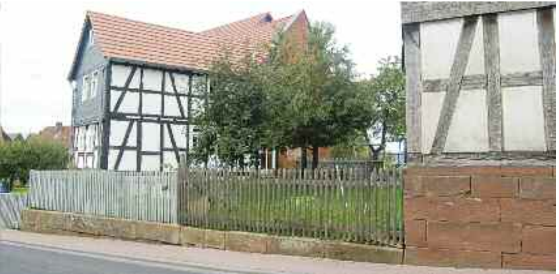
Bestehende Bebauung heute.
