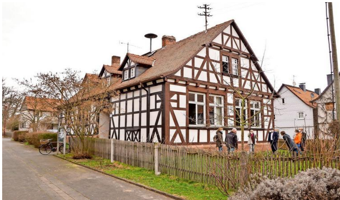
Die erste große Sanierungsphase der Alten Schule in Rauschholzhausen ist abgeschlossen. Für den Endspurt fehlen noch die Mittel. Quelle: Ina Tannert
