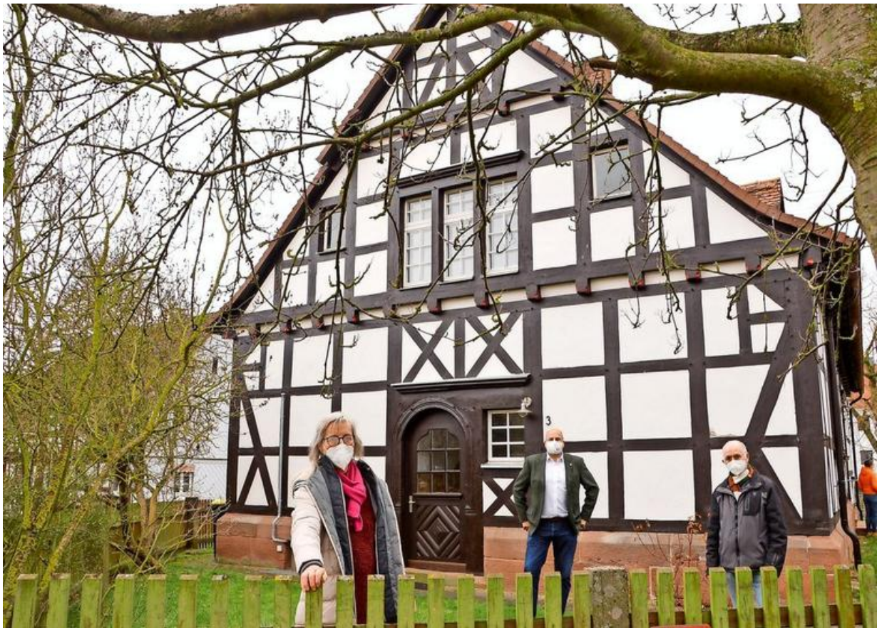
Annemarie Duske, Lutz Pauly (Mitte) und Helmar Allamode vom Vorstand der Dorfgemeinschaft Rauschholzhausen stellten den Fortschritt der Sanierungsarbeiten in der Alten Schule vor. Quelle: Ina Tannert
